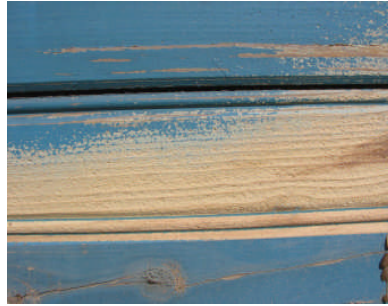
Resim 1.8: Kuşlama tekniği ile bir kısmı boyadan temizlenmiş yüzey
