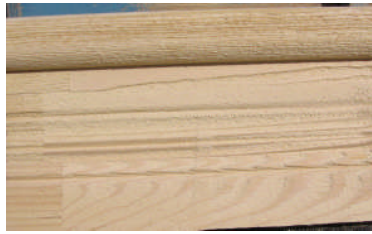
Resim 2.11: Kumlama tekniği ile aşındırılan söve
