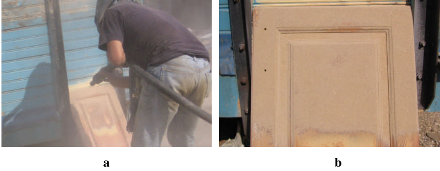
Resim 1.7: Kuşlama makinesi ile yüzeydeki boyanın temizlenmesi
