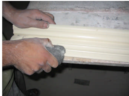
Resim 2.20: Astar boyanın alüminyum tel ile düzeltilmesi
