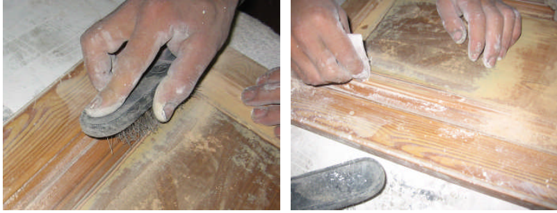
Resim 1.4: Tel fırça ve zımpara ile yüzeydeki boyanın temizlenmesi
